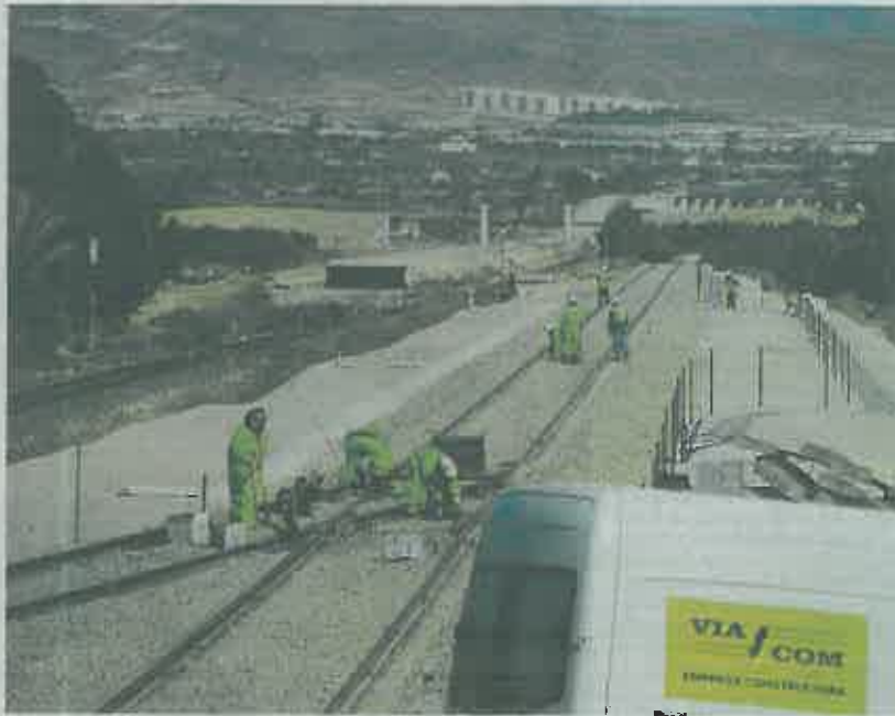
Trabajos en la línea de alta velocidad a su paso por el término municipal de San Isidro. ■ F.A.
